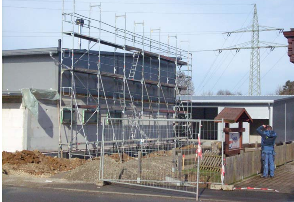
Bauhof Kusterdingen (Jahnstraße 58)
