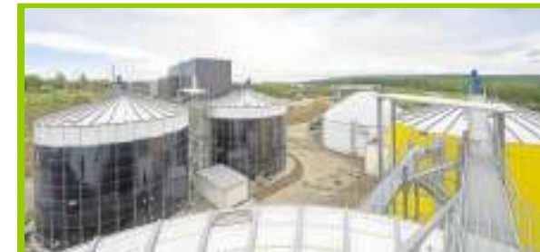
Biogasanlage eines lokalen Energieversorgers
